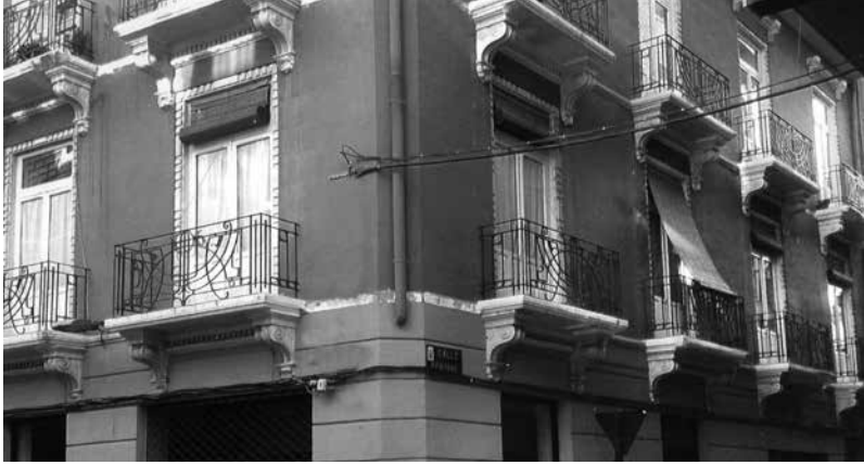
Casa familiar en la calle san Ginés, esquina con Sagasta.
